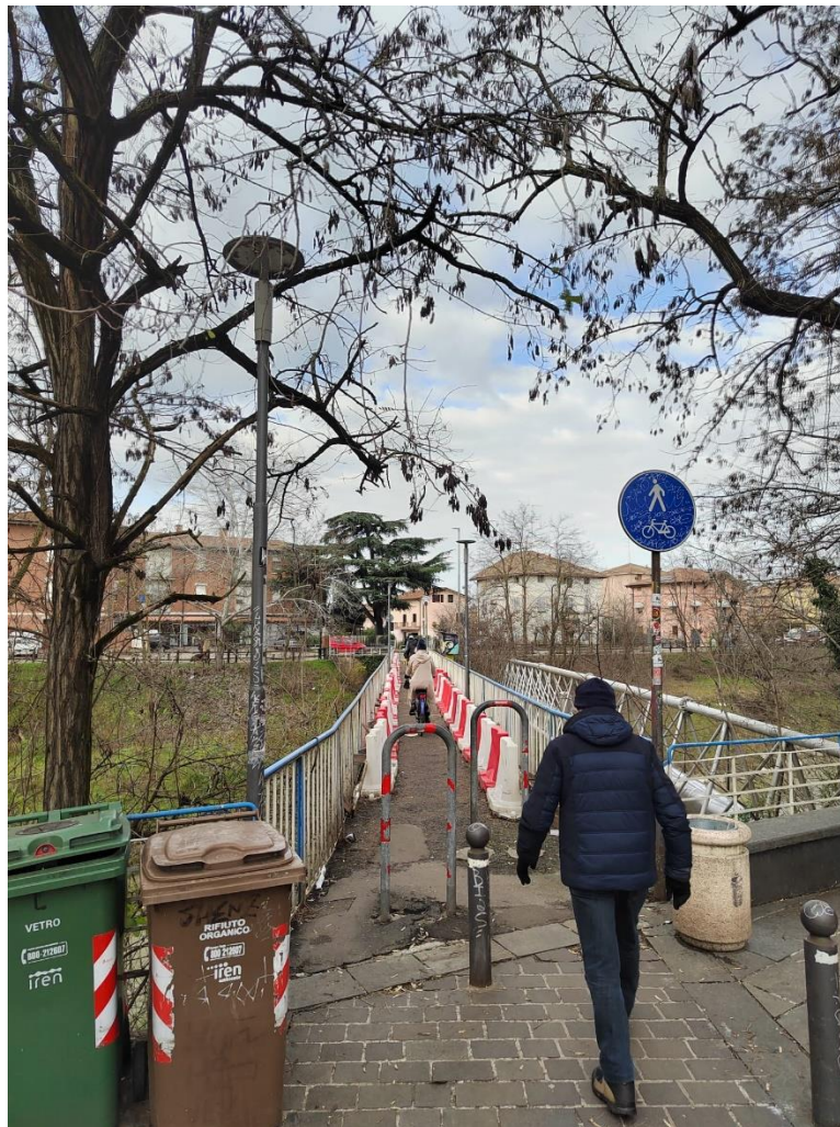
Passerella ciclopedonale Quartiere Gattaglio, foto del 27 Gennaio 2023
